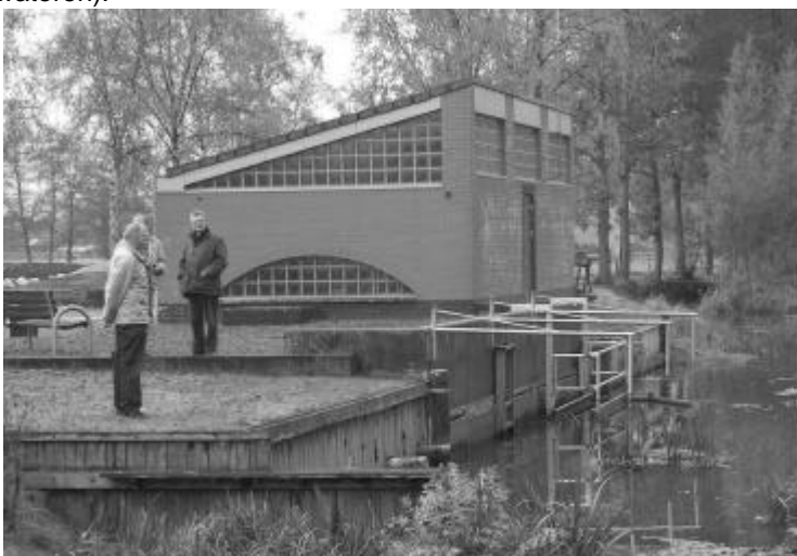
Het pompgebouw bij het waterinlaatpunt Zuuk, waar water uit de Klaarbeek en de Verloren Beek wordt ingenomen. Foto: Jacques Meijer.
